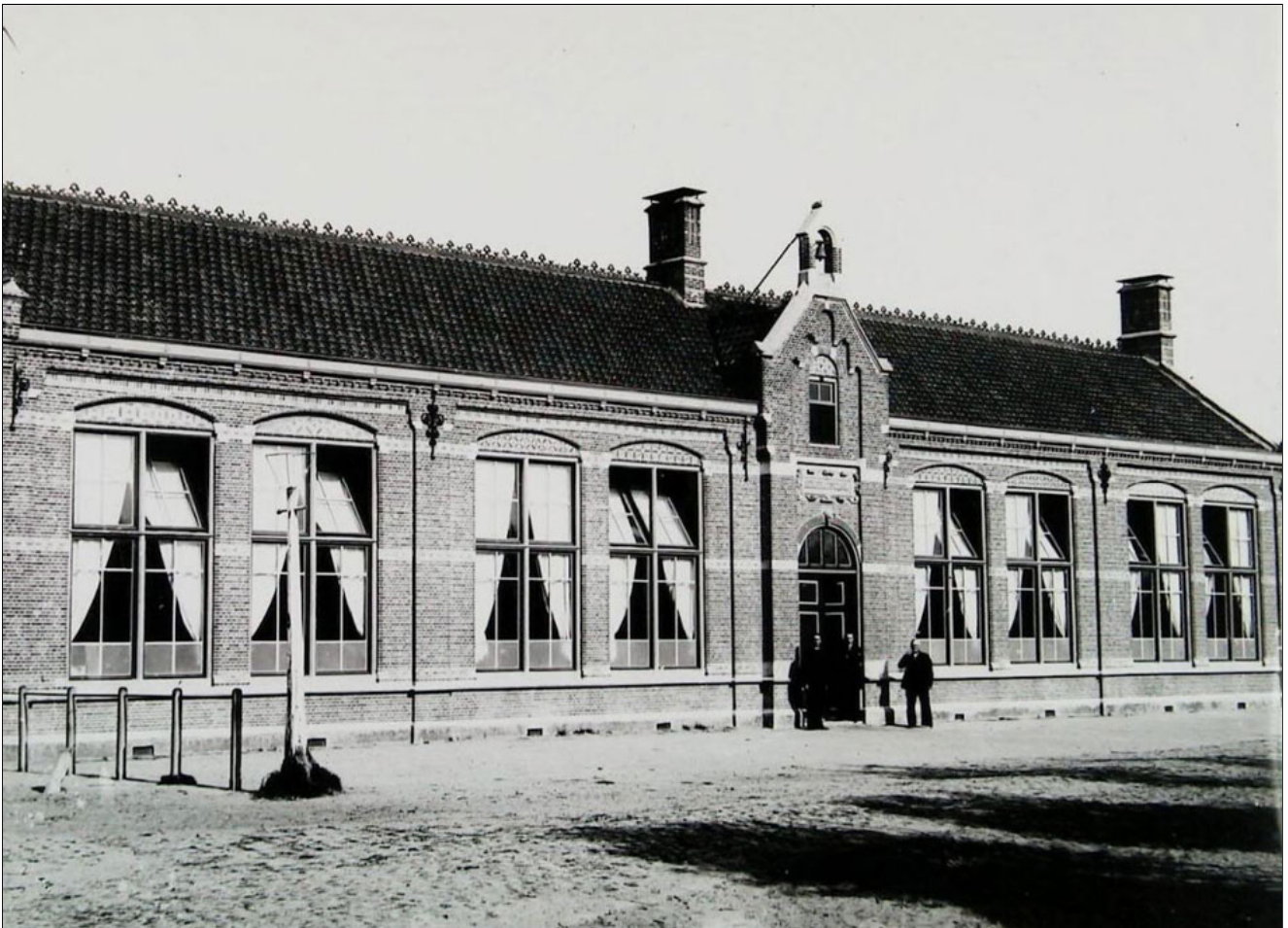
Foto uit 1905. In 1884 is een vierklassige middengangschool met geaccentueerde ingangspartij gebouwd door de gebr. Dekkers uit Westkapelle (B) naar ontwerp van bouwkundige L. Kuiler. De bouwkosten zijn f 16.940. Boven de ingang bevindt zich een cartouchein neorenaissance-stijl met als opschrift
